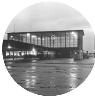
DIJK EN TERP Het station als een opgetilde reizigersmachine die zich in alle richtingen opent.
